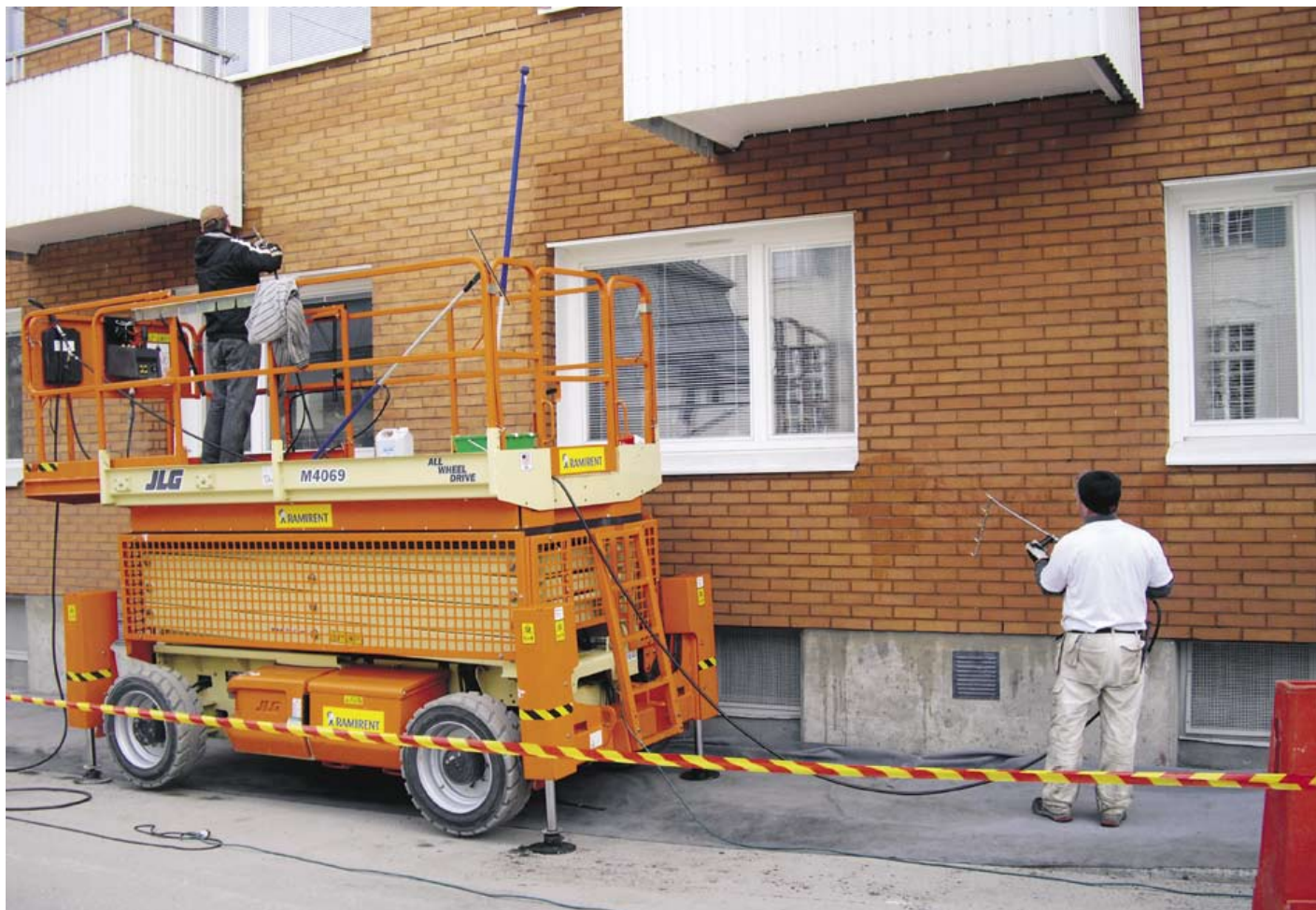
Fasadimpregnering i centrala Sundsvall under utförande av Norrlands Stenimpregnering AB.
